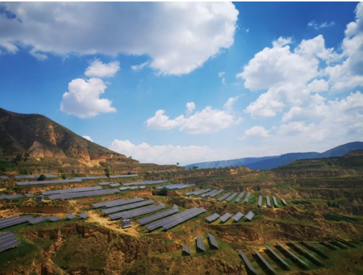
④ 东乡光伏发电项目
