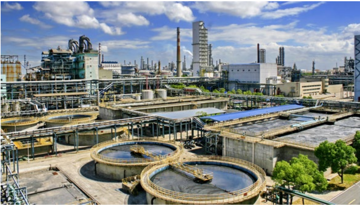
九江石化污水处理装置
